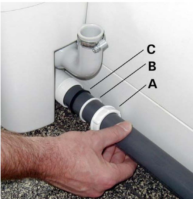
(Abb. 3) Stecken Sie nun die Überwurfmutter (Pos. A), den Druckring (Pos. B) und den schwarzen Keildichtring (Pos. C) wie Abgebildet auf die DN 40-Abflussleitung und schieben Sie diese bis zum Anschlag in die gewählte Zulauföffnung des Behälters. Befestigen Sie die Abflussleitung, indem Sie die Überwurfmutter am Zulaufstutzen festdrehen, dabei muss der schwarze Keil-Dichtring zwischen Überwurfmutter und Zulaufstutzen liegen. Verfahren Sie genauso, wenn sie weitere Sanitäranlagen anschließen möchten.
