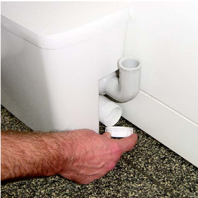
(Abb. 2) Entfernen Sie die Blindkappe, die auf den Zulaufstutzen geschraubt ist, und entnehmen Sie der Blindkappe den schwarzen Keil-Dichtring sowie den weißen Druckring.
