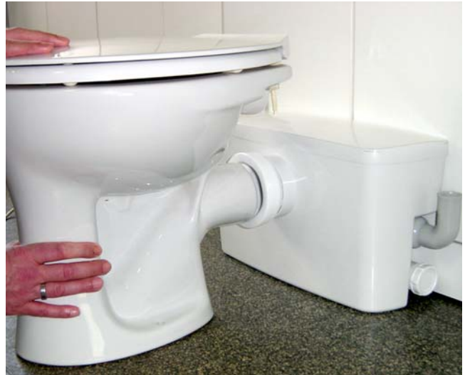
(Abb. 1) Stellen Sie das WC vor die Kunststoffbox und schieben Sie den WC-Stutzen in die Verbindungsmanschette der Anlage. Achten Sie unbedingt darauf, dass der Behälter der Saniflux nicht eingedrückt wird.
