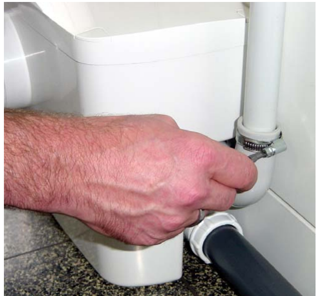
(Abb. 4) Zum Anschluss der Druckleitung befestigen Sie die 1" (DN 25)-Druckleitung im Abgangsbogen, der sich oben rechts am Behälter befindet, mit einer Schelle. Verlegen Sie die Druckleitung stetig steigend (im Idealfall erst senkrecht, dann waagrecht) in einer Schleife über das Niveau der Rückstauenebene des öffentlichen Abwasserkanals. Dies verhindert, dass bei einem Ansteigen des Wasserspiegels im Abwasserkanal, z. B. bei starkem Regen, Abwasser durch die Druckleitung in den Behälter der Saniflux zurückgedrückt wird. Führen sie die Druckleitung von dort direkt bis zum nächsten Sammelabfluss. Überprüfen Sie nochmals alle Anschlüsse und Verbindungen auf ihre Dichtigkeit. Stecken Sie nun den Stecker in eine geerdete Steckdose, die Hebeanlage ist jetzt betriebsbereit.
