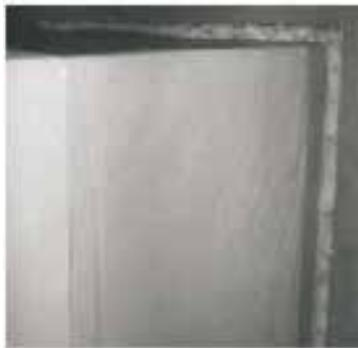
Luftkanäle müssen zentrisch am Lufteintritt der Wärmepumpe enden.
