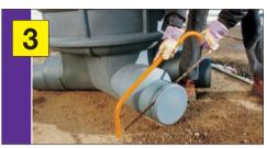
3. Die benötigten Zuläufe/Ablauf an der Schnittkante absägen.
