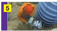
5. Schrittweises Verfüllen und Verdichten mit Schotter.
