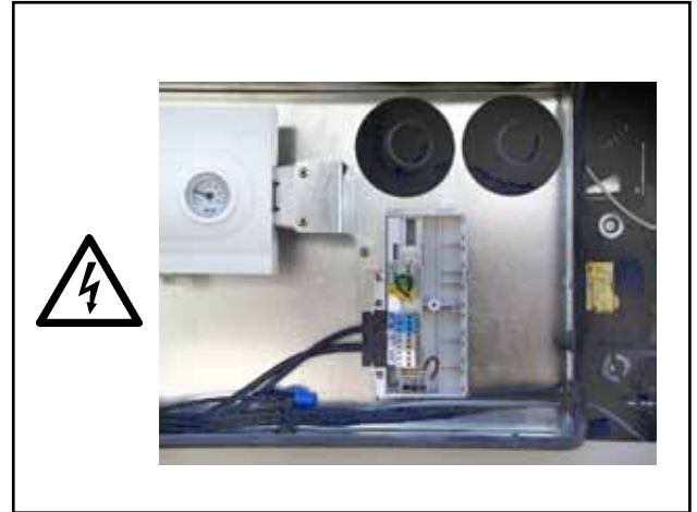
Bild: Anschlusskasten MGK-170/210/250/300 Gefahr durch elektrische Spannung
