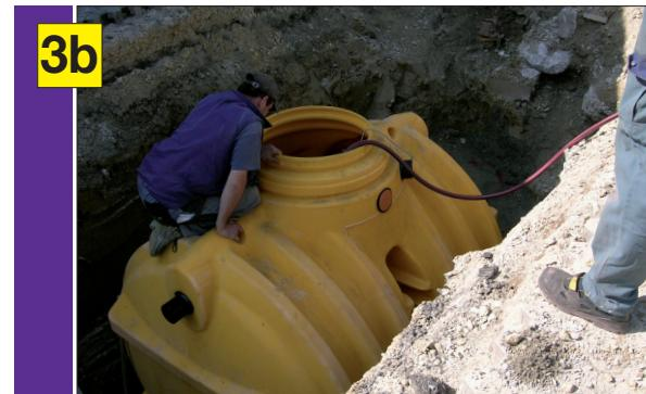
**Remblaiement avec du gravier 8/16 par étapes et compacter, remplir simultanément la cuve d'eau.**
