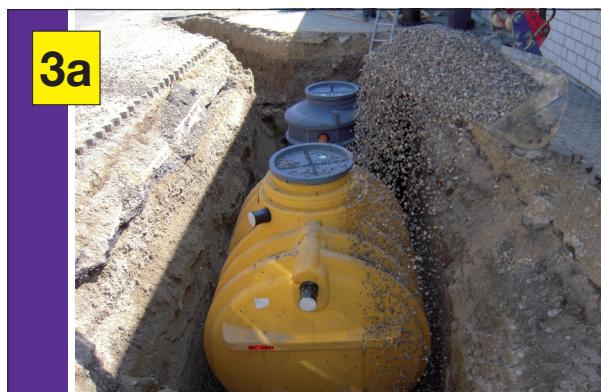
**Baugrube mit Schotter 8/16 lagenweise verfüllen und verdichten, gleichzeitig den Behälter mit Wasser befüllen, damit der Füllstand des Wassers der Verfüllung der Baugrube entspricht.**
