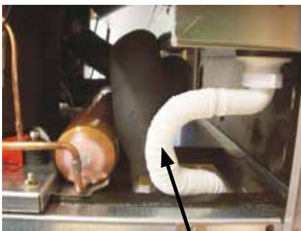
Kondensatablauf mit stetigem Gefälle verlegt
